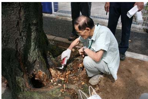
(写真 2.腐朽部除去後の炭化処理)
